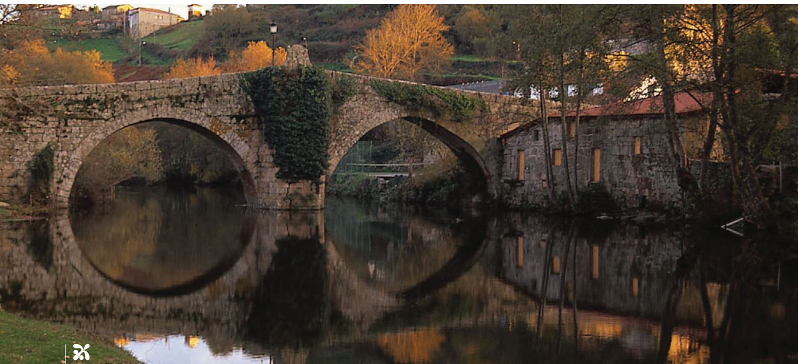
Ponte de Vilanova
